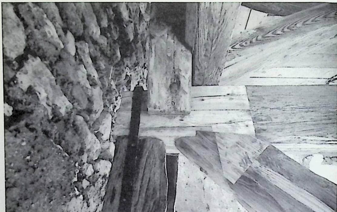
*Incastellatura delle campane: particolare di un nodo dopo il restauro – sostituzioni localizzate delle parti lignee degradate.*
